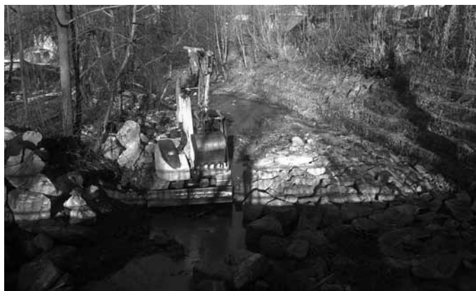
Prace przy moście w Juszczyźnie
