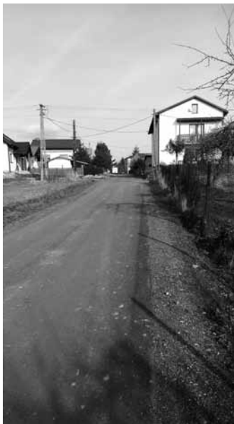
ul. Łukowa - wykonano
