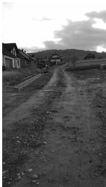
Droga do Duraja - trwają prace
