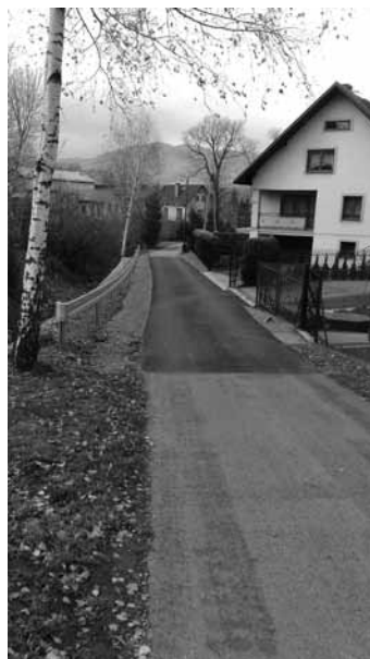
ul. Brzozowa - wykonano
