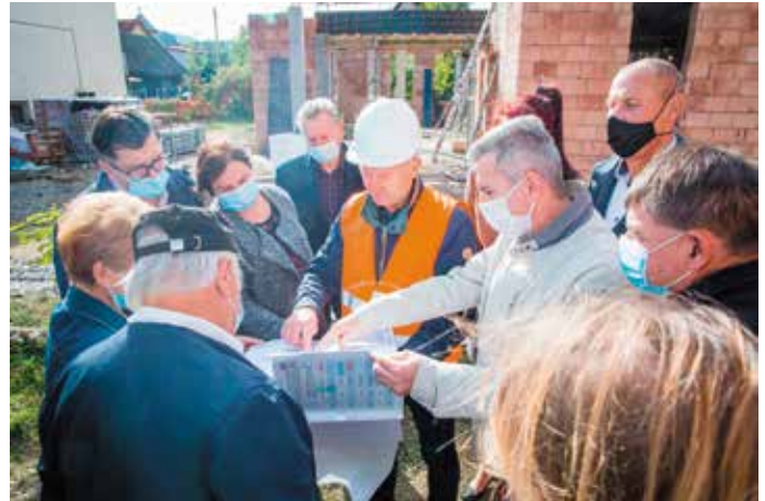
Wójt i Radni Gminy Radziechowy-Wieprz na miejscu budowy podczas komisji objazdowej
