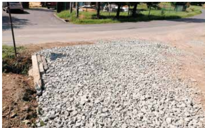
Przybędza Oblasek - zdjęcie prac w toku realizacji
