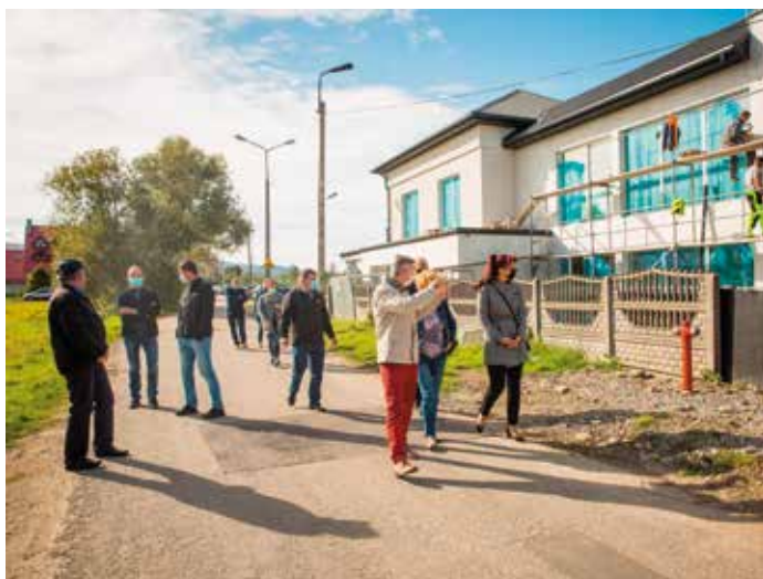
Wójt i Radni Gminy Radziechowy-Wieprz na miejscu budowy podczas komisji objazdowej
