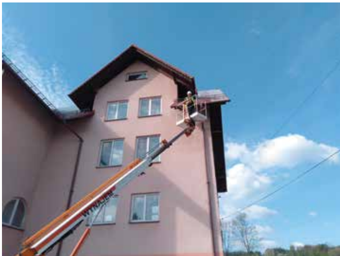
Czyszczenie ryni i naprawa w Budynku Wielofunkcyjnym w Brzuśniku
