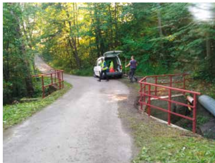
Brzuśnik – naprawa barierek mostu, prawy groń
