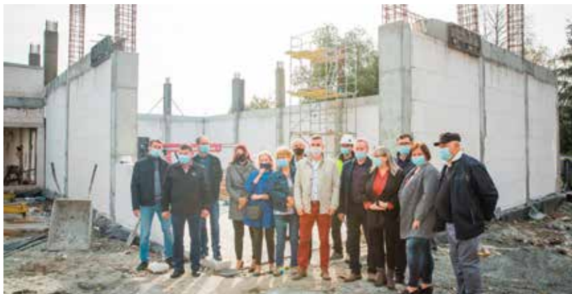
Wójt i Radni Gminy Radziechowy-Wieprz na miejscu budowy podczas komisji objazdowej w Przybędzy
