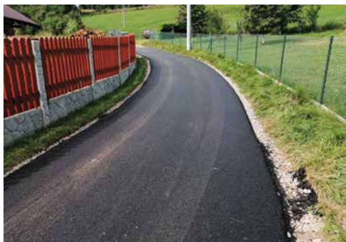
Juszczyna droga do boiska
