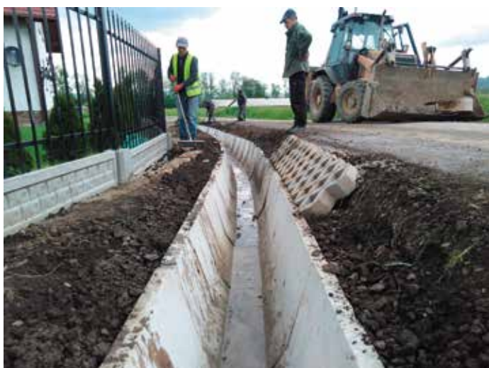
Ul. Nowy Dwór w Wieprzu – układanie korytek, umacnianie drogi
